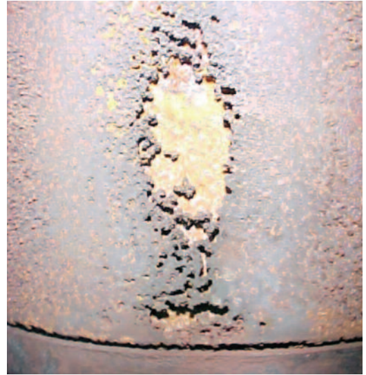
Fig. 6.1.3 Cavitación sin corrosión
